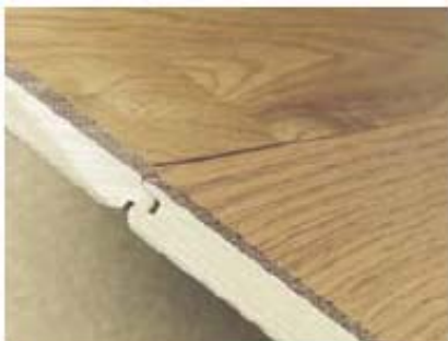
1. výškové rozdíly ve spárách
