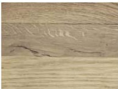
7. trhlinky ve dřevě
