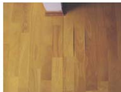
9. poškození vodou
